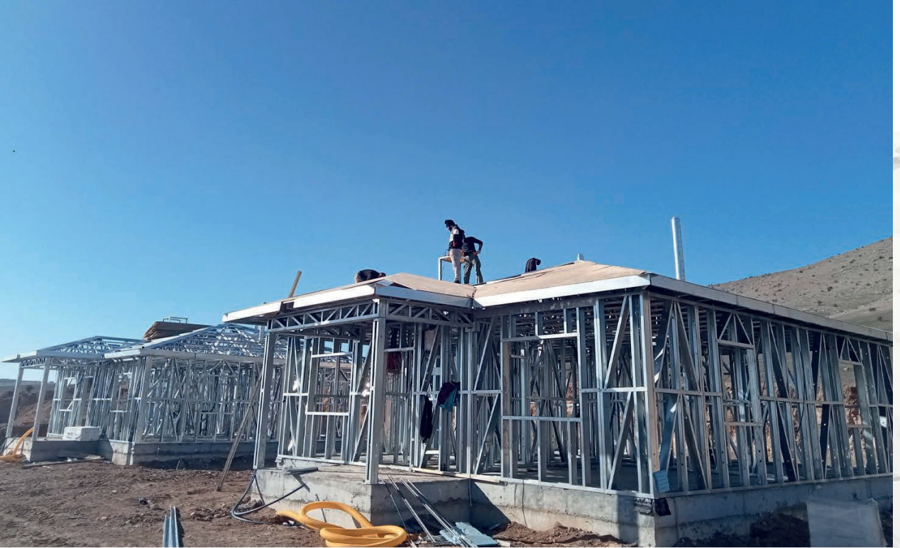
● Yuva Köy Çelik Köy Ev Yapımı Projesi
